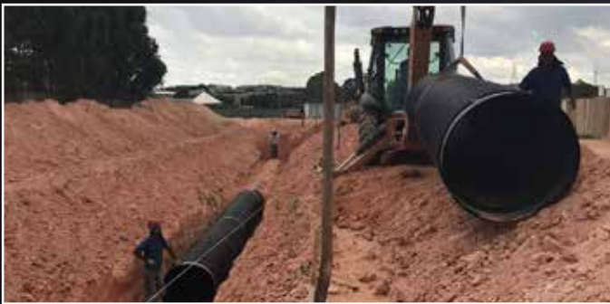
Implantação da rede de drenagem com tubo PEAD DN800mm na Avenida Maria da Glória em Contagem - MG
