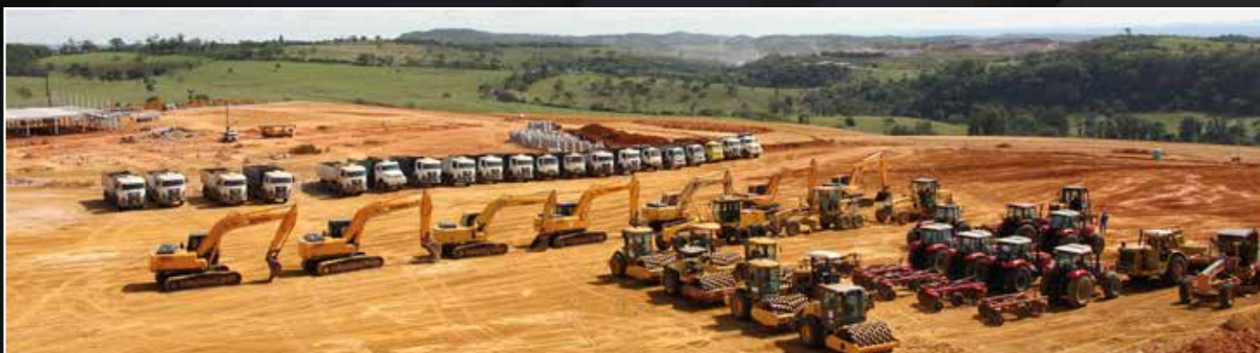
Terraplenagem do platô do Fashion City em Pedro Leopoldo - MG
