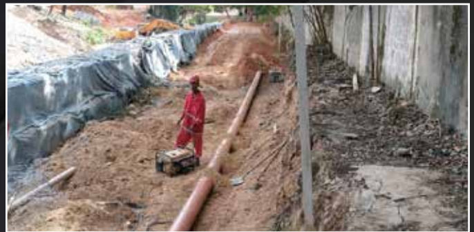
Implantação de interceptor de esgoto com tubo PVC Ocre JE DN250mm.
