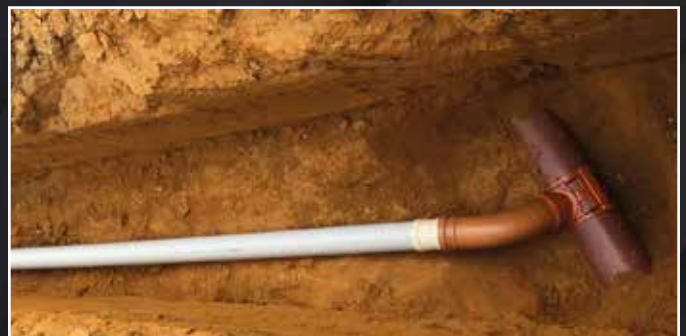
Implantação de ligações de esgoto com Selim e poço luminar no loteamento Gameleira em Belo Oriente - MG
