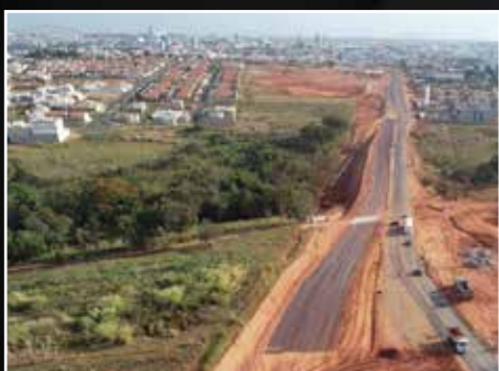
Terraplenagem da implantação da Avenida Hítalo Ross em Araxá - MG
