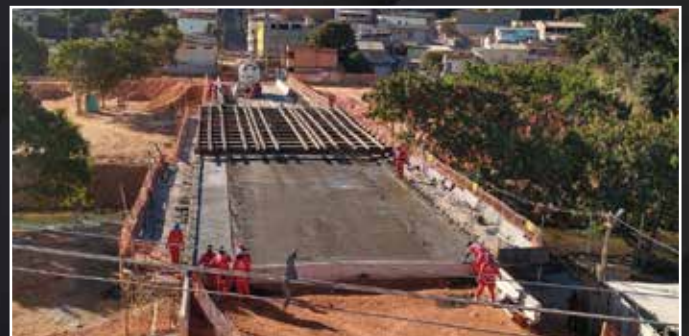
Concretagem e forma invertida no tabuleiro da ponte.
