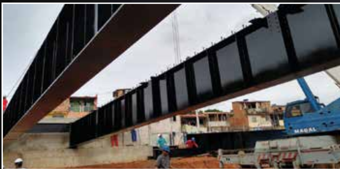
Implantação de vigas metálicas com aço SAC350 na ponte no bairro São Bernardo.
