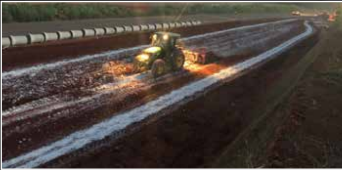
Tratamento do Subleito com mistura de solo e cal na Avenida Hítalo Ross em Araxá - MG.
