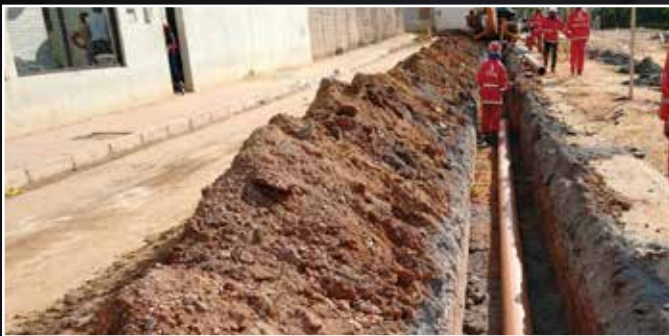
Implantação de rede de esgoto com tubo PVC Ocre JE DN200mm.
