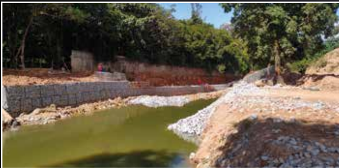
Contenção em gabião revestido em PVC do interceptor da COPASA.
