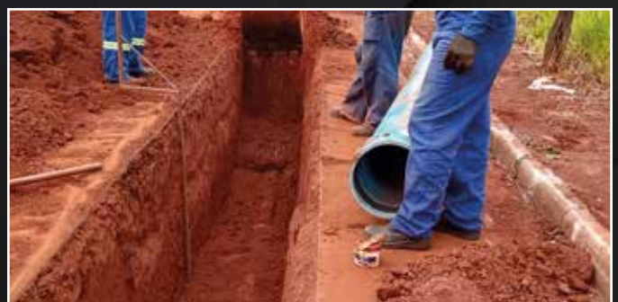
Implantação de rede de abastecimento de água com tubos DEfofo em Ituiutaba - MG
