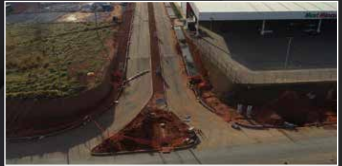
Pavimentação em CBUQ da Avenida Tenente Coronel Hermenegildo Magalhães entroncamento com Hítalo Ross em Araxá - MG.
