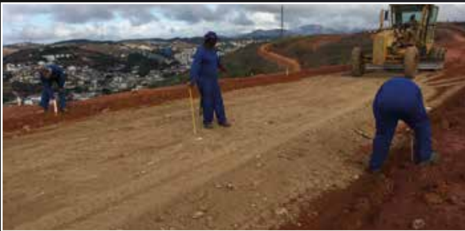
Tratamento da Base com bica corrida no loteamento Horizontes da Serra em Ubá - MG.
