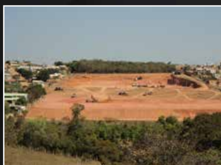
Terraplenagem para implantação do novo Hospital de Divinópolis - MG
