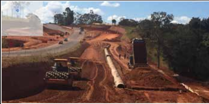
Implantação da rede de drenagem com tubo de concreto PB JR DN800mm
