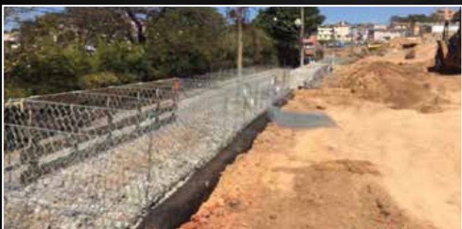
Início da contenção em gabião do terreno da DAF.
