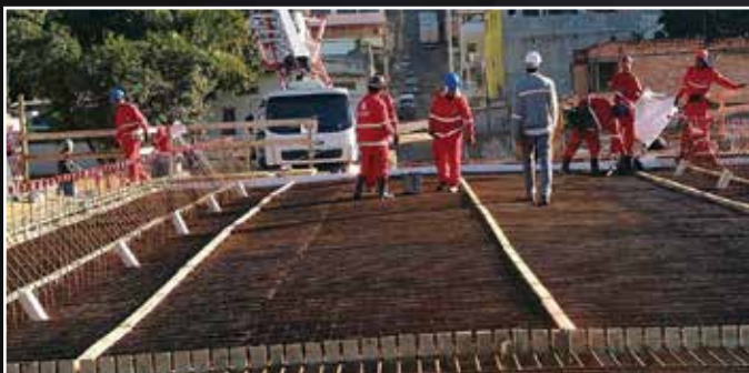
Armação do tabuleiro da ponte sobre as vigas metálicas.
