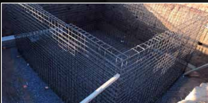
Bloco de ancoragem para curva de adutora de água bruta de FoFo DN450mm em Ubá - MG
