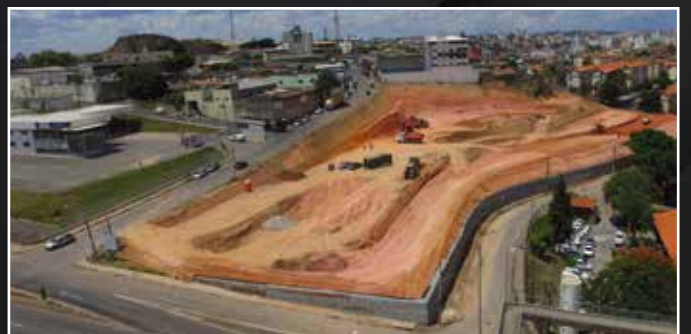
Vista de cima de toda a contenção em gabião da nova sede da DAF - VIA TRUCKS em Contagem - MG (Obra concluída em 2018).
