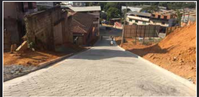
Pavimentação Intertravada do loteamento Horizontes da Serra em Ubá - MG.
